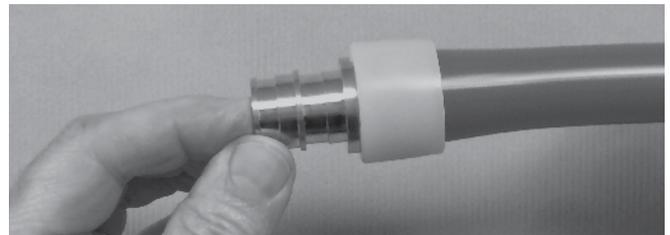
5. Inserte rápido la conexión en la tubería/aro expandido hasta que el retén o apoyo de la conexión toque la tubería/aro. Mantenga la conexión en su sitio hasta que la memoria del tubo/aro se contraiga de manera anular en ella.
